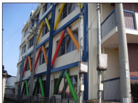
北側耐震補強
