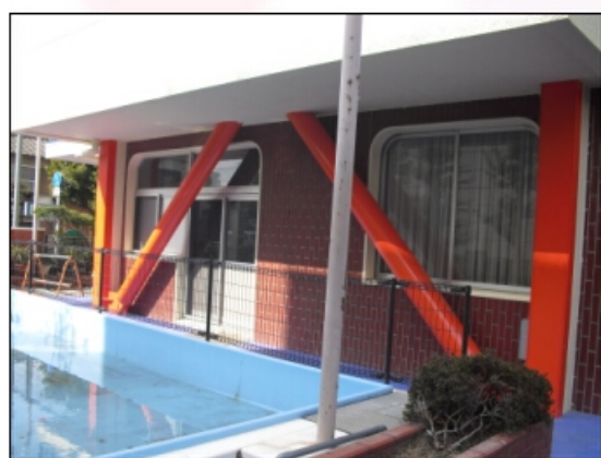
南側耐震補強
